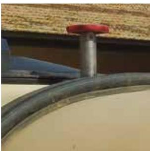
Figura 14. Dispositivo de vaciado del depósito.
